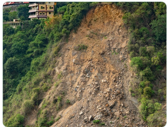
Ladera deslizada bajo un grupo de viviendas
