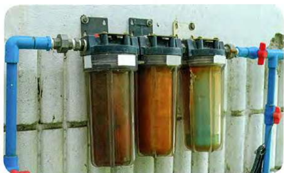
DECANTACIÓN DE AGUAS RESIDUALES
