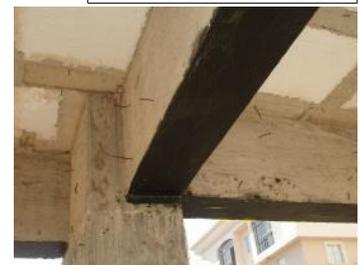
**3.1.) DINTEL:** Viga maciza que se apoya horizontalmente sobre dos soportes verticales y que cierra huecos tales como ventanas y puertas. Soportan esfuerzos de flexión.
