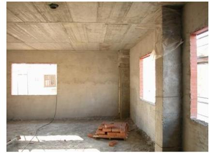
**\*Hormigón:** Es una mezcla de **cemento, arena, agua y grava**, que fragua y se endurece. Se utiliza en la fabricación de hormigón armado, vigas, pilares, cimientos y estructuras en general.
