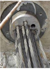
En el **hormigón pretensado** se incluyen cables de acero que se tensan con gatos antes de verter el hormigón en el encofrado. Cuando el hormigón fragua, se liberan los tensores de las sujeciones. Así se aprovecha la ligera contracción que experimenta el hormigón al fraguar.
