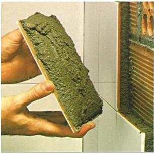
**\*Mortero:** Es una mezcla de **cemento, arena y agua** que sirve para unir los ladrillos, baldosas o las piedras. Se usa también para hacer revoques, es decir, cubrir de una fina capa las paredes exteriores de las viviendas (**enfoscado**).
