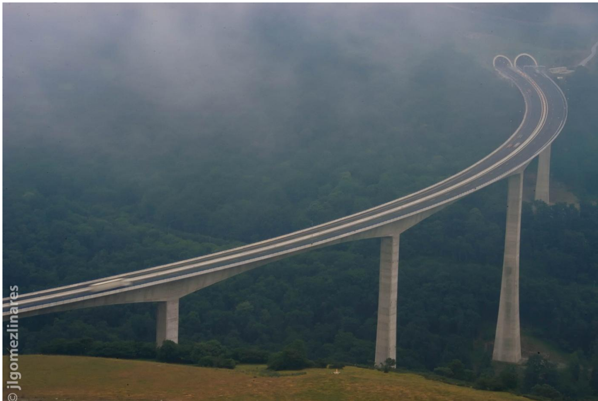
Viaducto de Montabliz (Cantabria)
